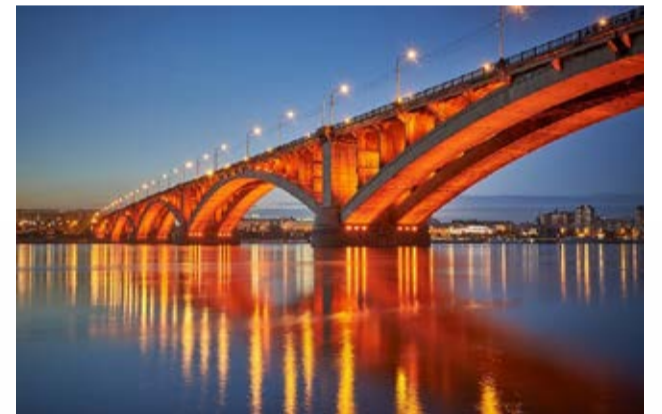
Коммунальный мост, г. Красноярск
