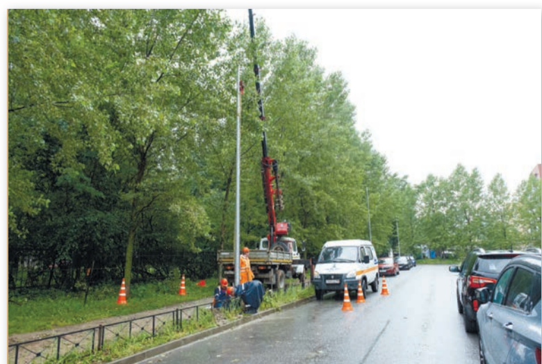
Строительство наружного освещения, ул. Звездная
