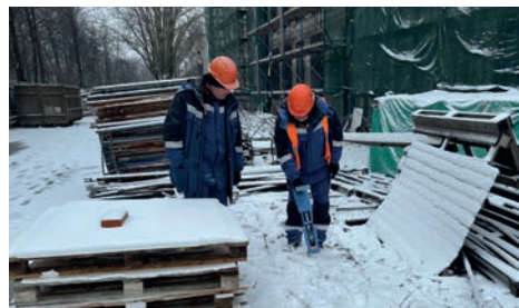
Проверка линии с помощью локатора
